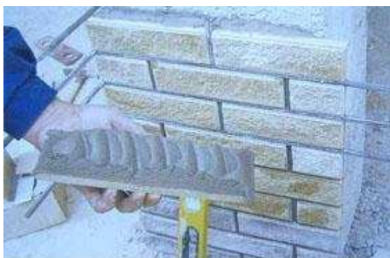
На плитку укладывается раствор.
