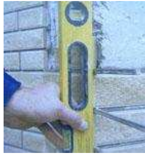
Выравнивается вертикально и горизонтально с помощью отвеса.
