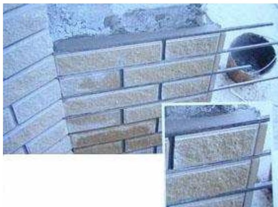
Прут укладывается на край плитки. Кладка заполняется раствором до уровня прута.
