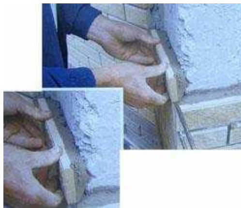
Плитка прикладывается к стене.
