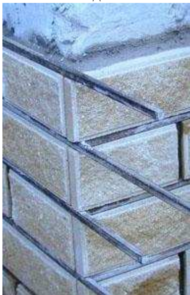
Кладка осуществляется при помощи прута размером 8x8 мм или 10x10 мм
